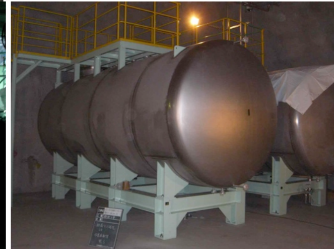
新空洞・LS貯蔵タンク
