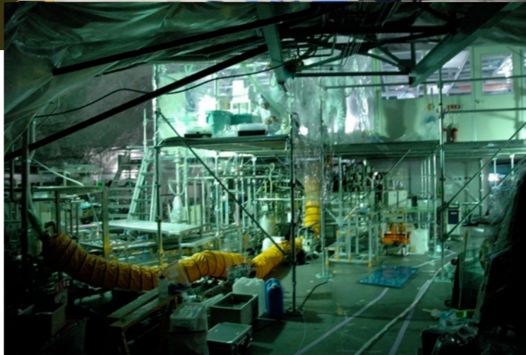
ドーム内クリーンルーム
