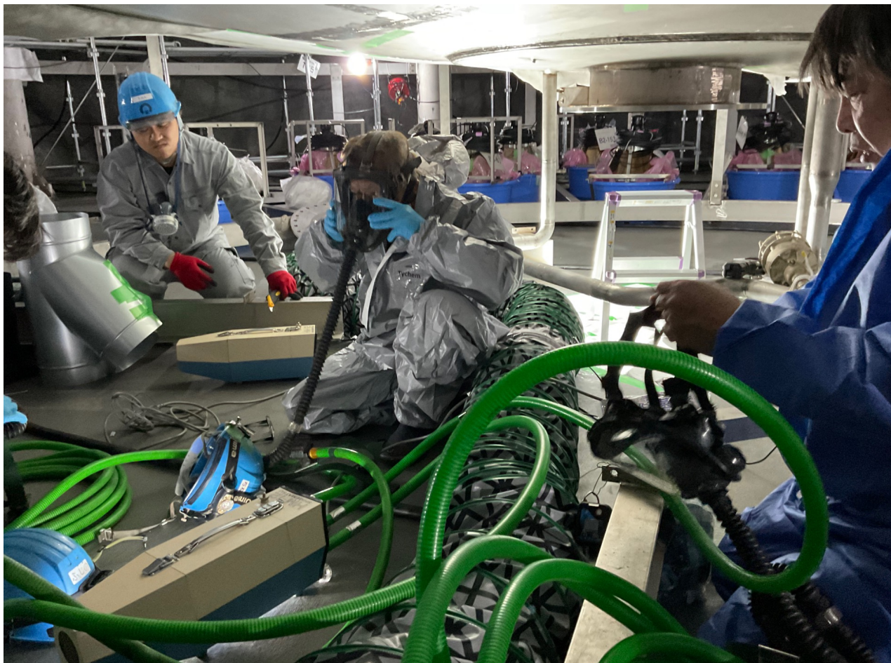
2/17 嚴重装備で内部へ侵入
